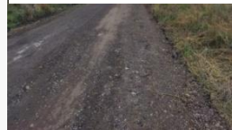
РЕМОНТ УЧАСТКА АВТОМОБИЛЬНОЙ ДОРОГИ В ЩЕБЕНОЧНОМ ИСПОЛНЕНИИ ПОС.ГОРЛИНКА
