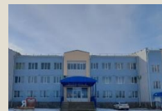
РЕМОНТ ФАСАДА МБОУ СОШ № 22 Г.ИПАТОВО
